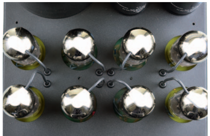
Nur für Servicepersonal: Kleine Bohrungen im Chassis schaffen Zugang zu den Potis, mit denen auf geringstmögliche Gleichspannung am Ausgang abgeglichen wird. Ansonsten bleibt die Haube zu.
